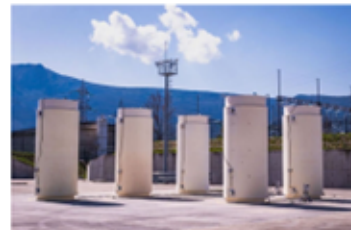
ENUN 52B Uso: CN Sta. Mª de Garoña Tipo: Doble propósito Diseñador: ENSA Capacidad: 52 EC
