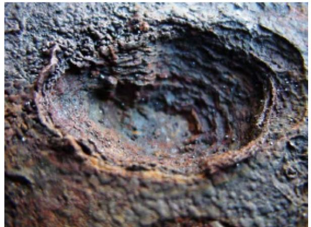
**Figura AII.2: Detalle de tubería afectada por tuberculaciones.**
