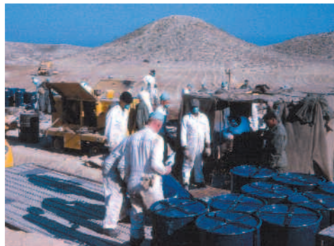
Labores de remedio del material superficial.
