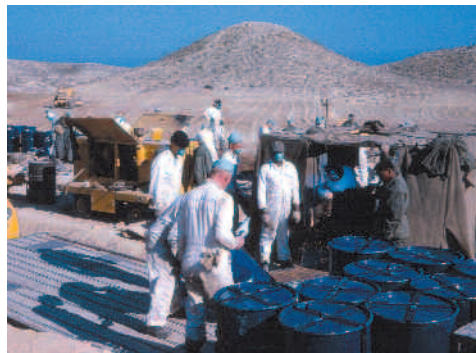
Labores de remedio del material superficial.
