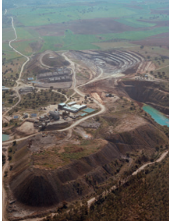
Vista aérea de la planta Lobo-G.
