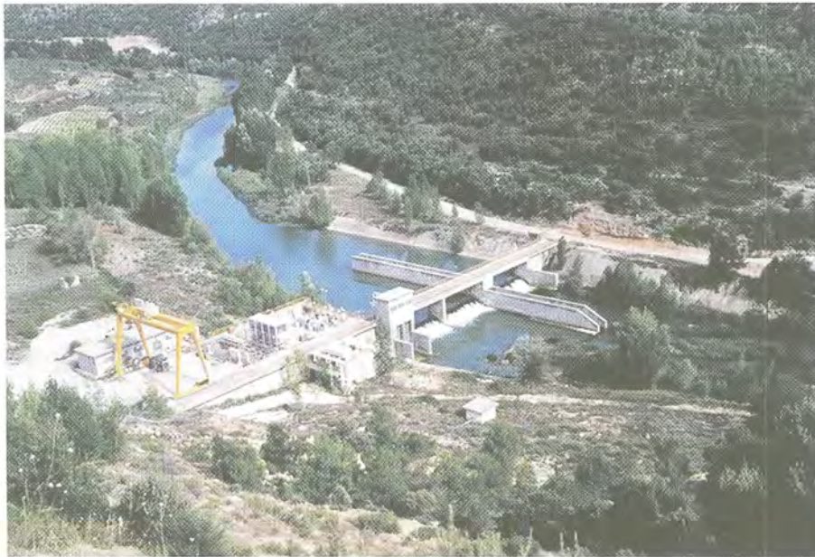
Fotografía 2.2. Embalse de la Ermita y sistemas de toma y vertido de agua de la central nuclear de Trillo.
