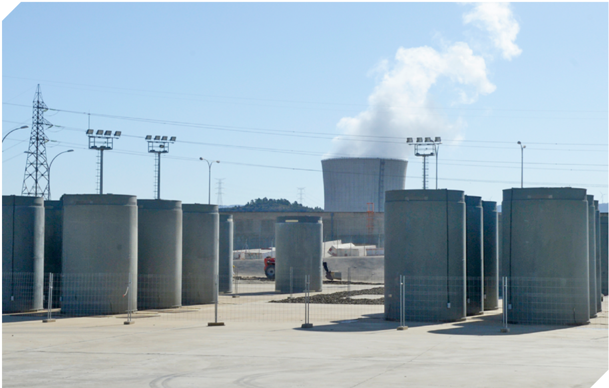
Vista del ATI de la Central Nuclear de Ascó.
