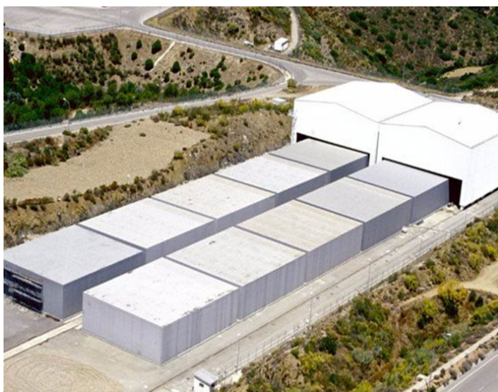
Imagen de celdas de RBMA del Centro de almacenamiento de ENRESA en El Cabil.
