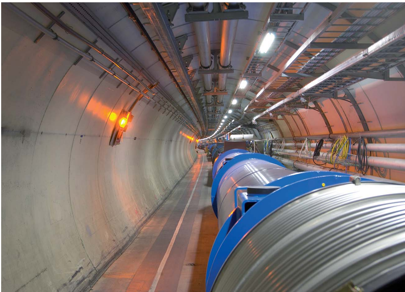
El LHC utiliza imanes superconductores para acelerar las partículas hasta alcanzar casi la velocidad de la luz.
