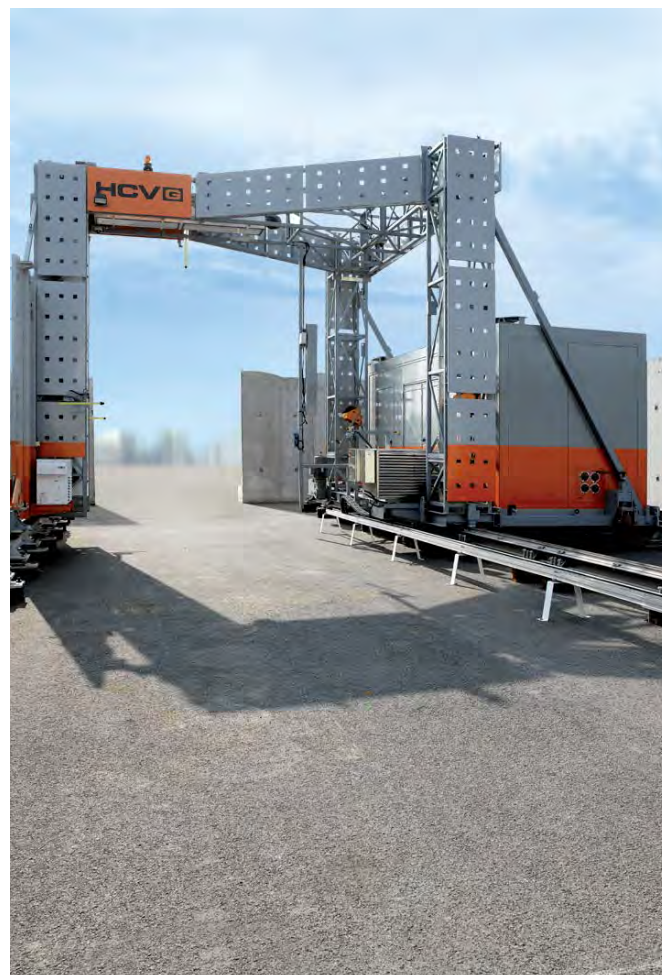
Pórtico detector de radiactividad a la entrada de una acera.
