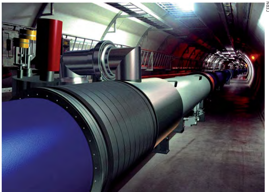
Parte del túnel de 27 kilómetros por el que circula el LHC.
