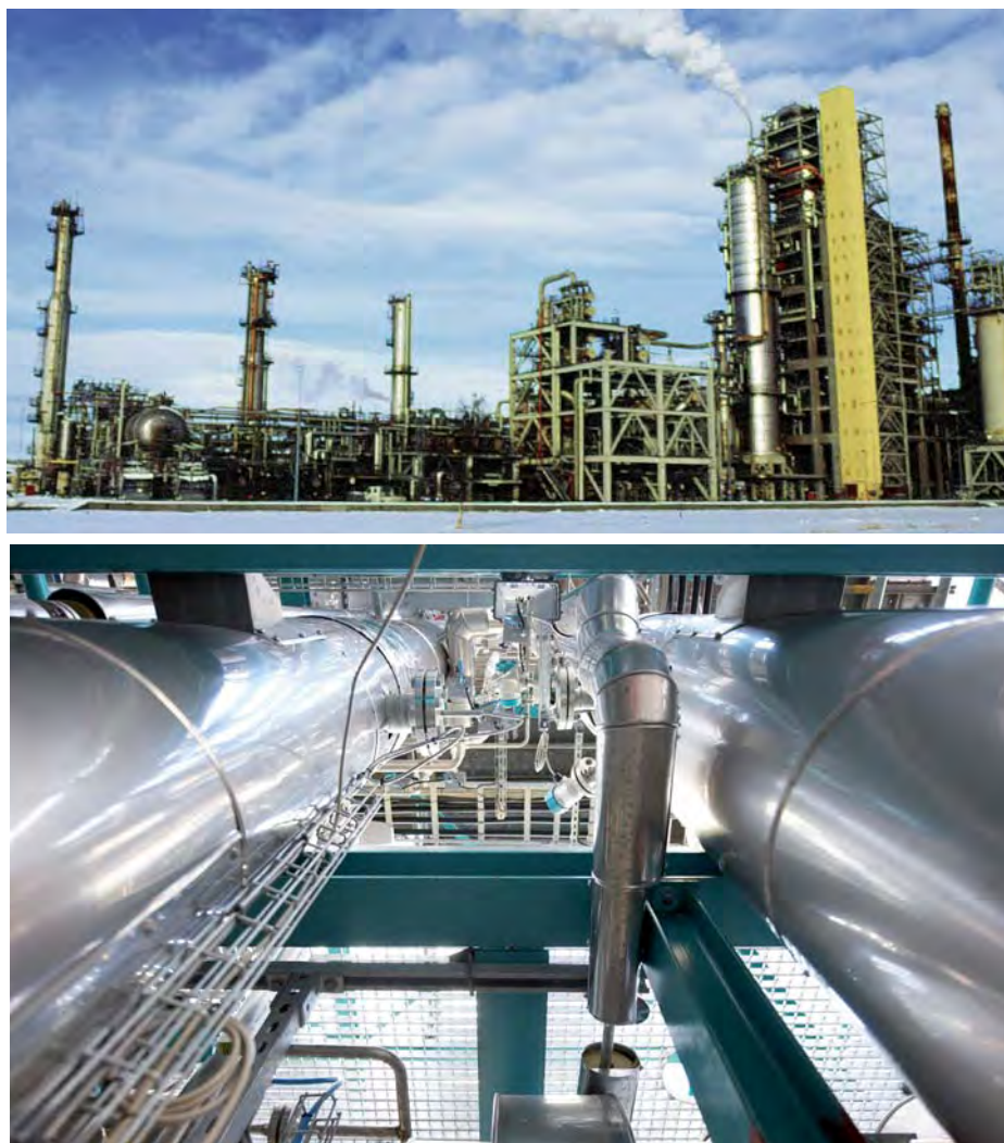
Vista general y detalle de la planta experimental de Mongstad, en Noruega.
