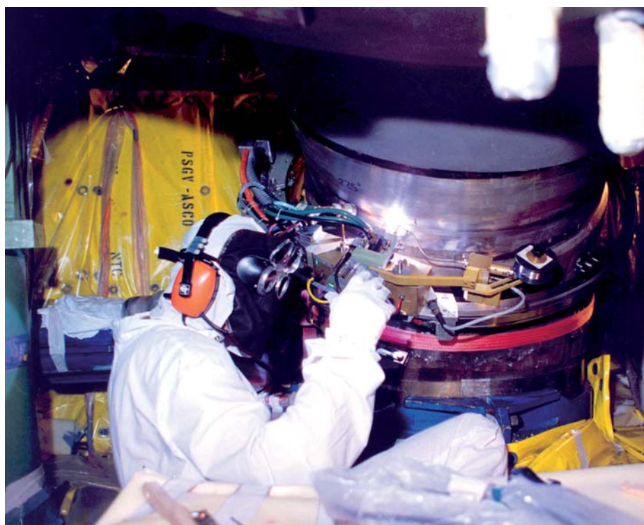
Cambio de los generadores de vapor en la central nuclear de Ascó.
