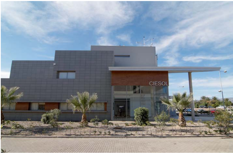
Edificio CIESOL del Cimat en la Universidad de Almería.
