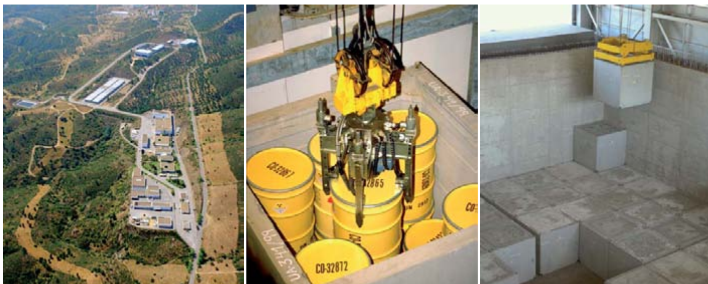
Vista aérea del almacén de residuos de baja y media actividad de El Cabril. Manejo automatizado de los bidones con los residuos y los contenedores donde se alojan.
