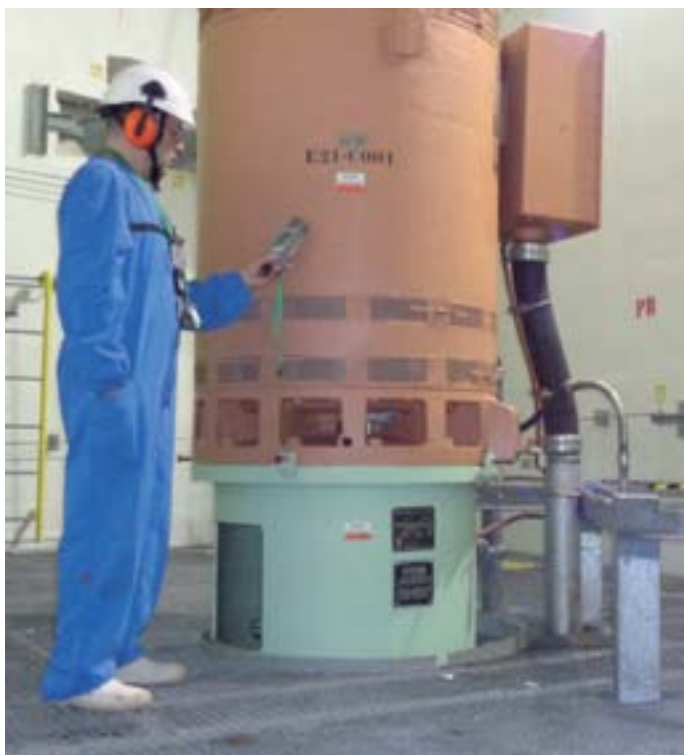
Control de las tasas de radiación en las proximidades del motor de la bomba del sistema de aspersion del núcleo a baja presión.
