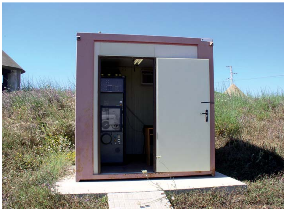
Estación de la REA en Tarifa.
