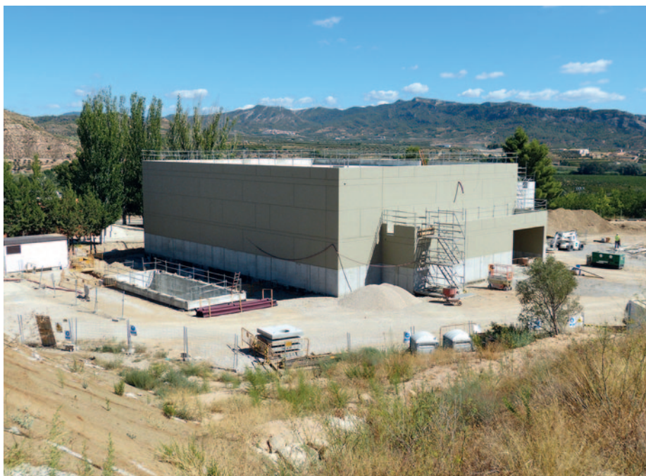
Construcción de un Centro Alternativo de Gestión de Emergencia (CAGE).
