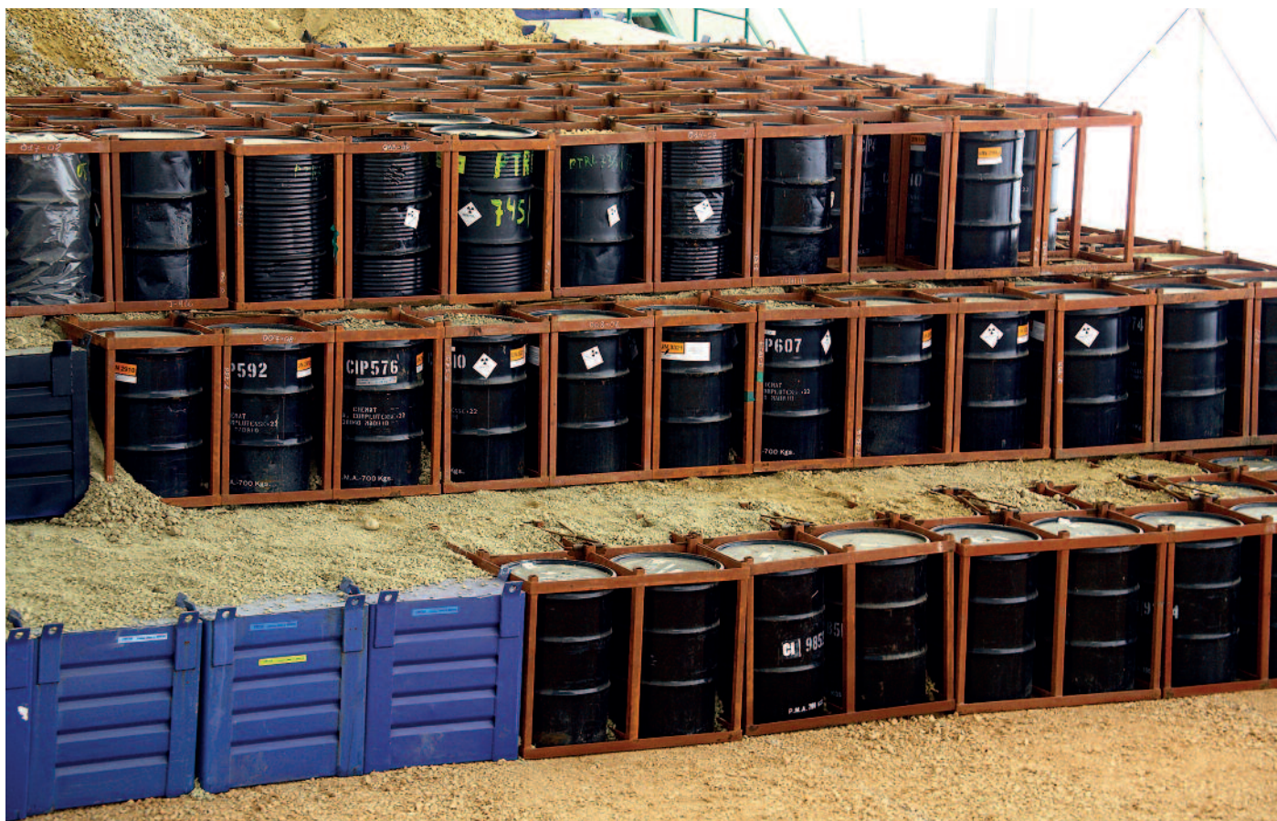
Almacenamiento de residuos radiactivos de muy baja actividad, en las instalaciones de El Cabril.
