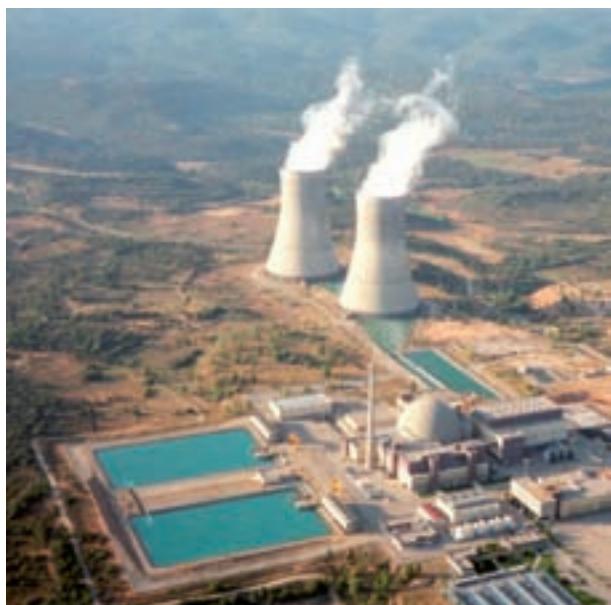
Vista aérea de la central nuclear de Trillo.
