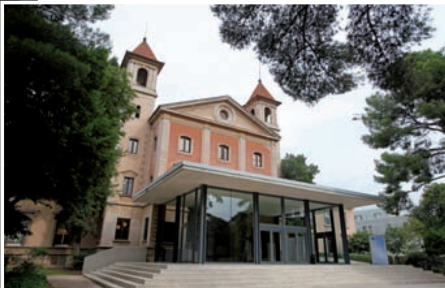
Entrada a la antigua capilla que alberga hoy el MareNostrum.
