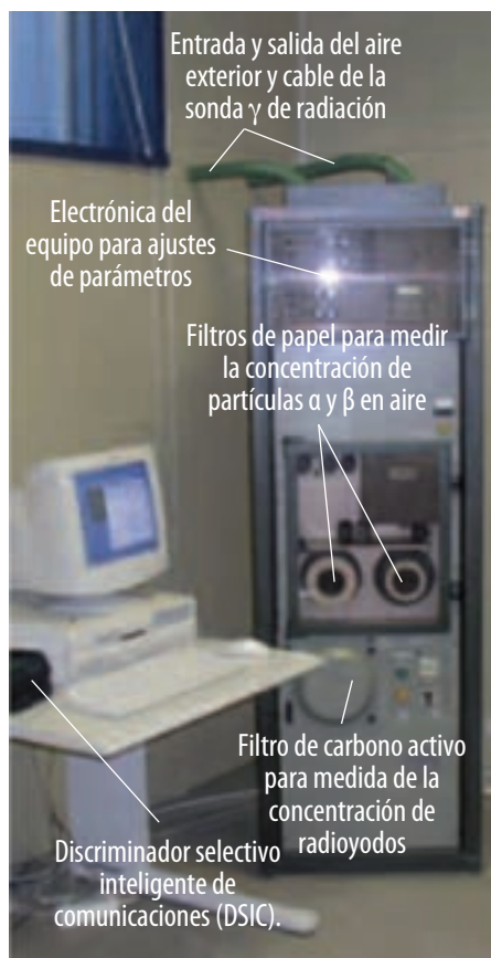
Figura nº 2. Antigua estación de la REA.
