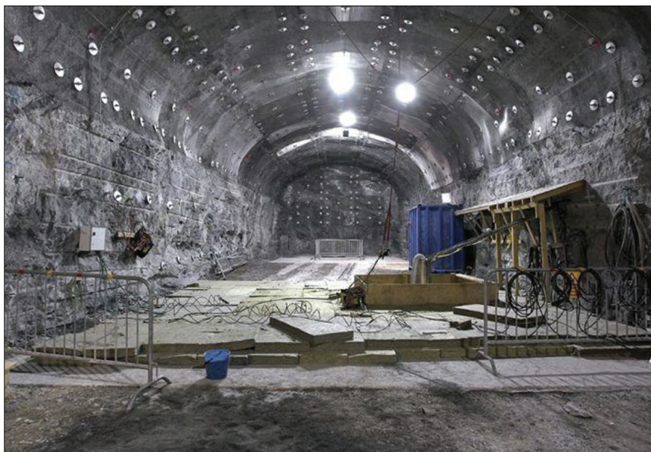
Construcción del AGP de ONKALO, en Finlandia.
