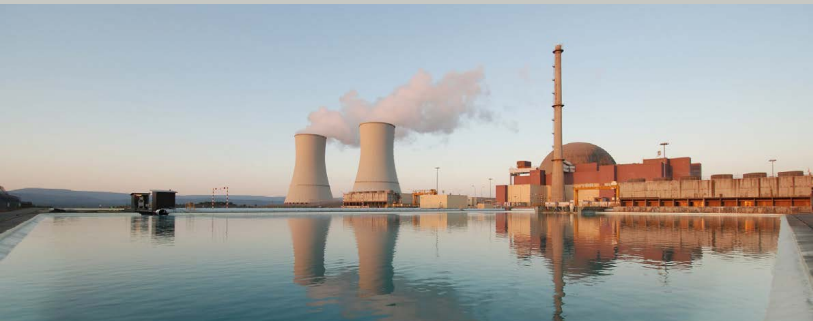
Imagen de la central nuclear Trillo
