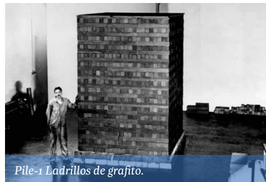
Ilustración del Chicago Pile-1, el primer reactor nuclear en conseguir una reacción en cadena autosostenida. Diseñado por Fermi, consistía en uranio y óxido de uranio en un recipiente cúbico con grafito incrustado.
