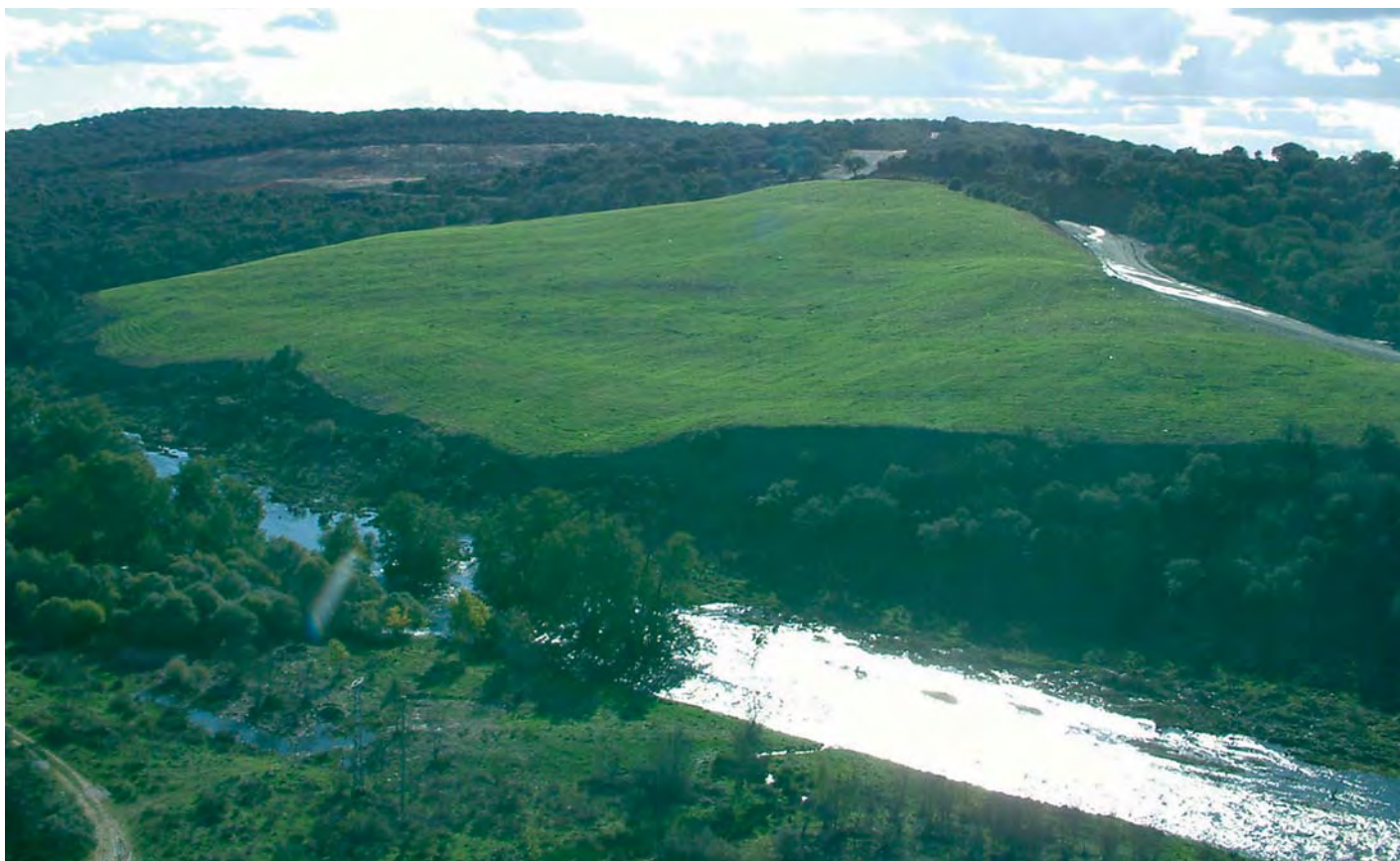
Vista de la mina D, en Saelices el Chico, una vez restaurada [octubre 2005].
