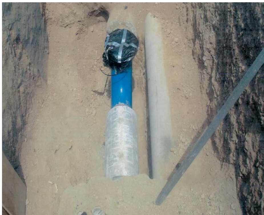
Figura 6. Sellado de las líneas de tubería Bonna de 300 mm del sistema EF.
