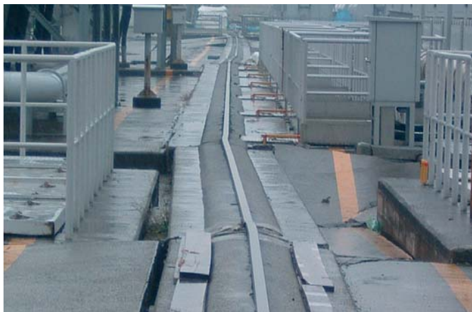
Efectos del terremoto del pasado mes de julio sobre las instalaciones de la central nuclear japonesa de Kashiwazaki-Kariwa.
