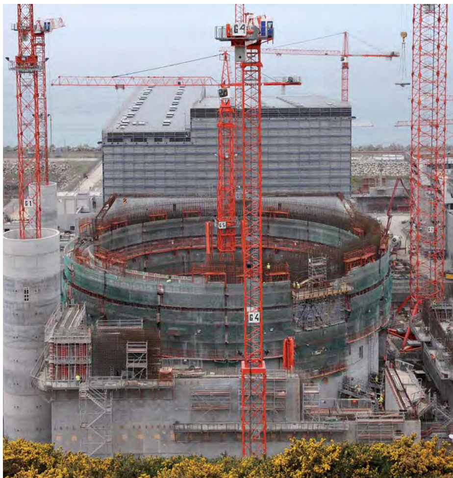
Construcción de la nueva central EPR de Flamanville en Francia.
