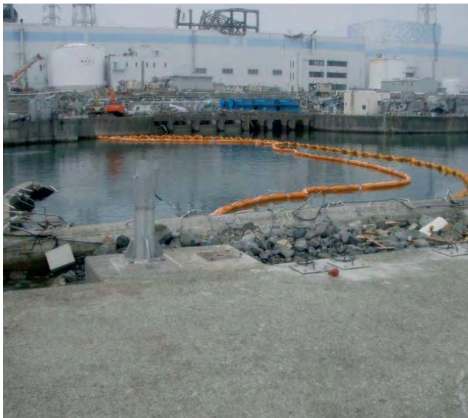
Detalle de las barreras de protección.
