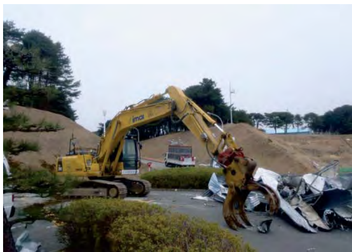
Grúa teledirigida recogiendo escombros.
