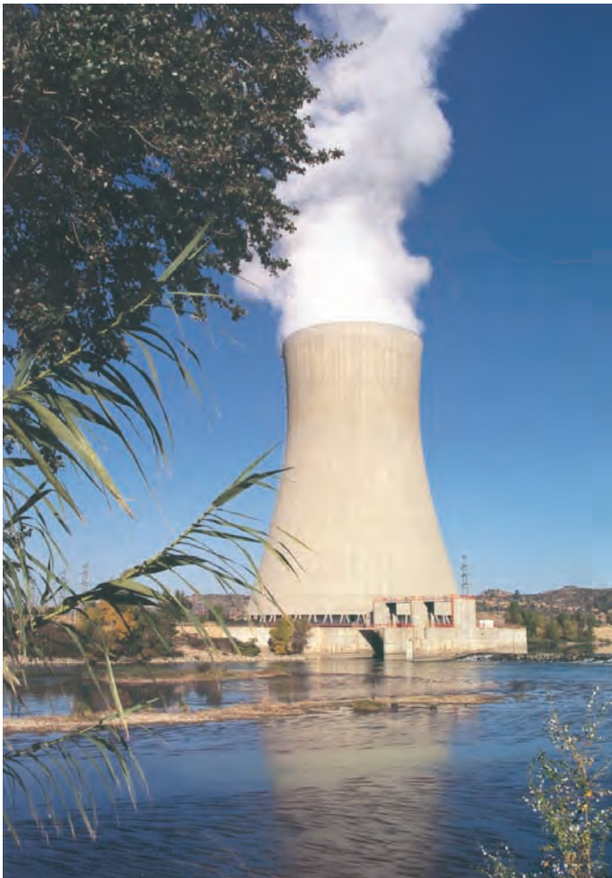
Torre de refrigeración de la central nuclear de Ascó.
