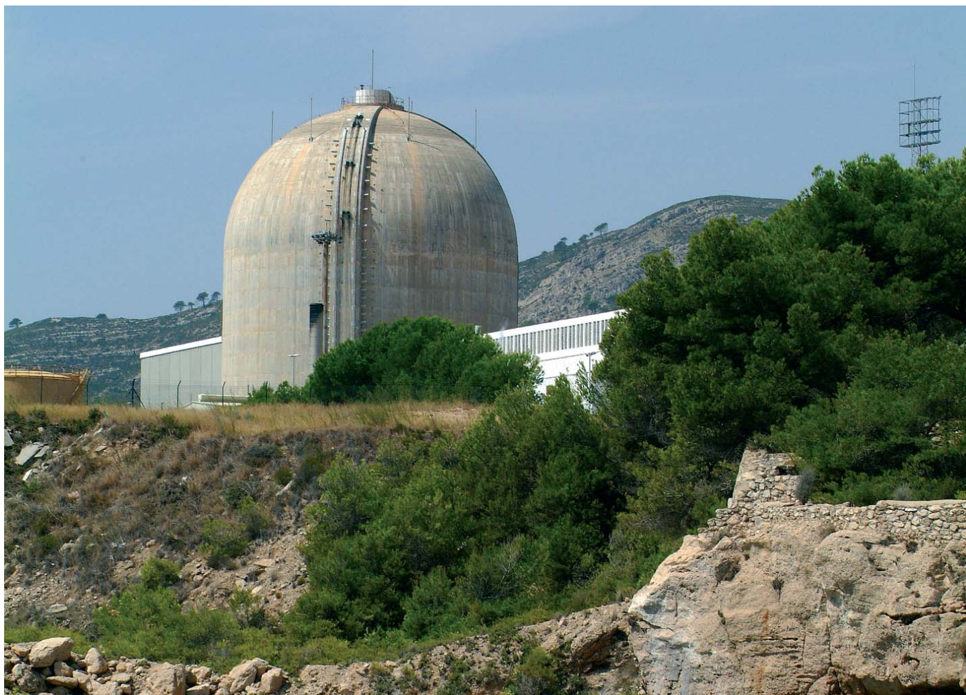
Vista exterior de la central.
