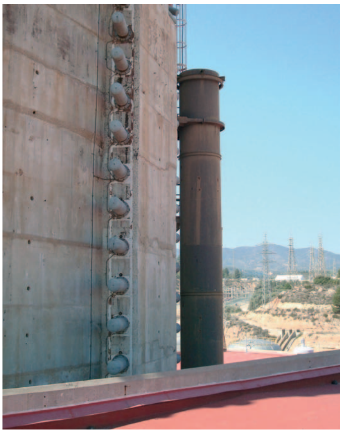
La chimenea vista desde la terraza de combustible.
