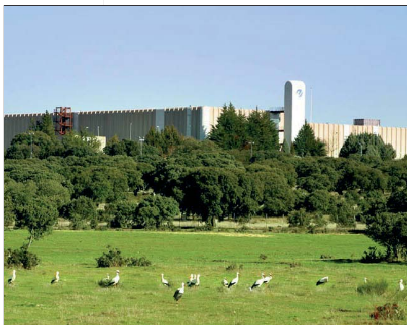
Fábrica de combustible de Juzbado (Salamanca)
