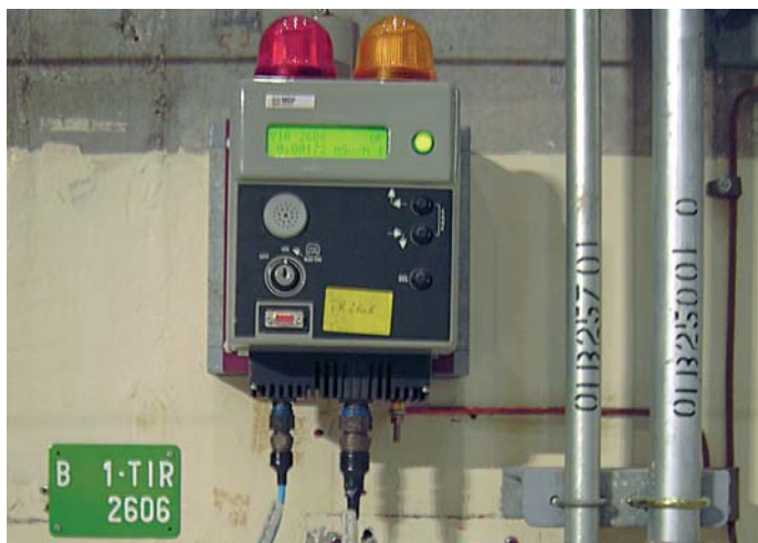
Monitor de radiación TR2606.
