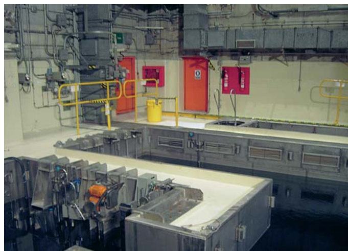
Vista lateral de la piscina, con el canal de transferencia al fondo.
