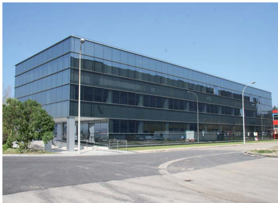
Vista general de las instalaciones de Equipos Nucleares S. A. en Maliaño, Santander.
