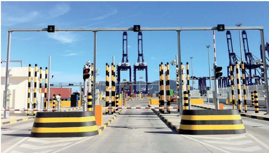
Instalación de Megaport en el puerto de Algeciras.
