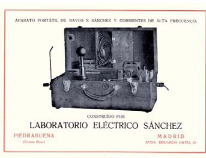
Uno de los componentes electrónicos fabricados por Mónico Sánchez. Imagen procedente de un folleto comercial sobre el aparato portátil de rayos X Sánchez.
