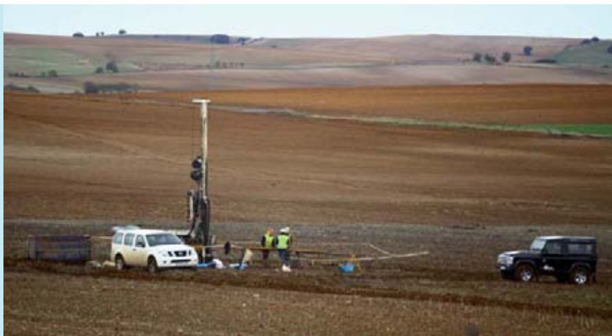
Realización de sondeos en el terreno donde se instalará el ATC.
