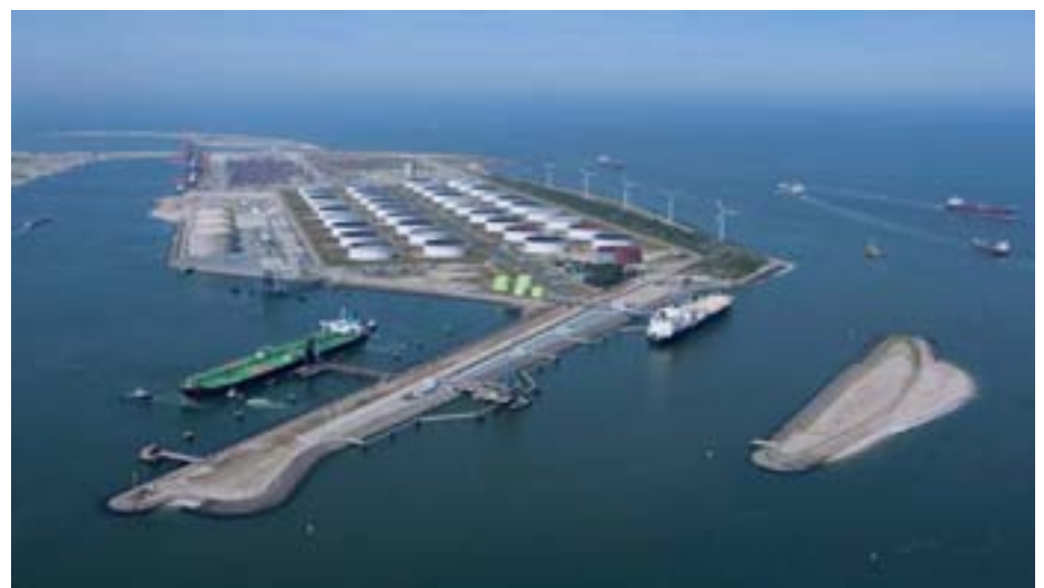
Planta de regasificación Gate Terminal, en Róterdam (Holanda).
