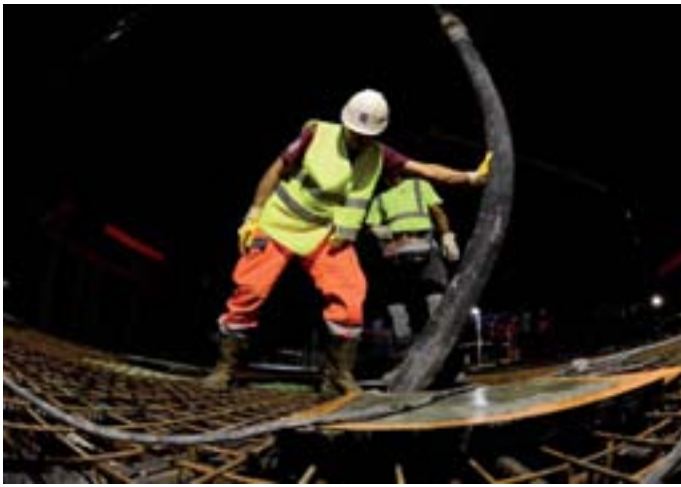
Izquierda, para avanzar en la construcción se trabaja también de noche. Abajo, vista aérea del estado de la construcción en la primavera de 2014.
