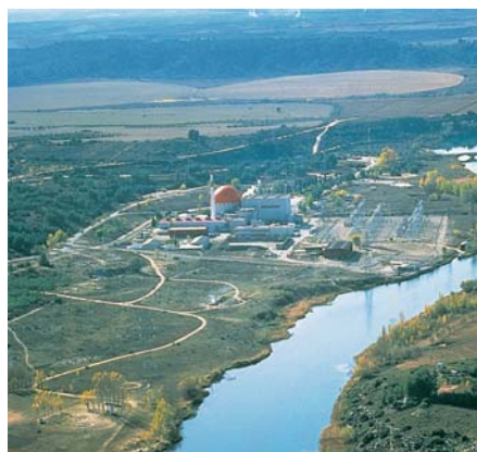
Vista de la central nuclear José Cabrera antes del inicio de su desmantelamiento.
