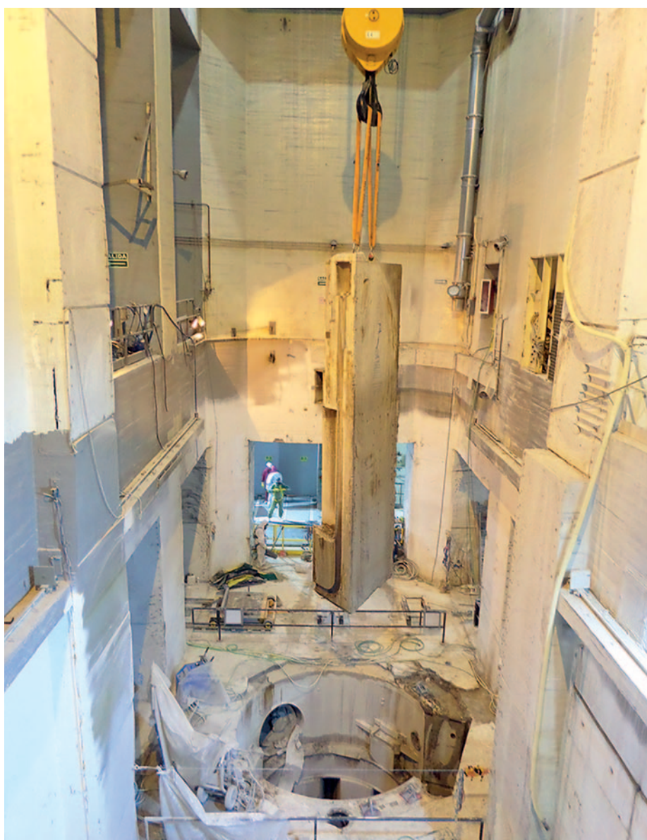
Interior de la central nuclear José Cabrera: extracción de pieza del blindaje biológico del reactor. De esta zona, se han extraído muestras para el proyecto CEIDEN sobre hormigones (Foto: Enresa)
