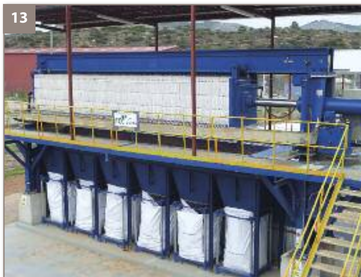
13. EL RESIDUO GENERADO (LAS "TORTAS") SE ALMACENA EN BIG-BAG. Adecuados para su posterior gestión por Enresa.
