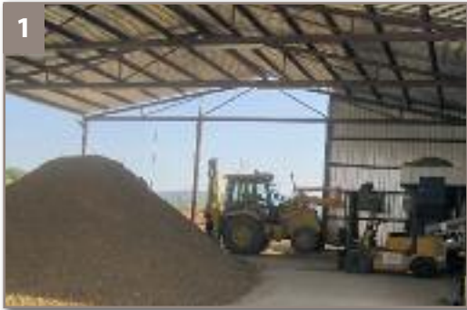
1. ALIMENTACIÓN DE MATERIAL. Previamente, se separa el material de tamaño superior a 100 mm en la zona de acopio de entrada. Posteriormente, se aporta el material en la tolva de la plataforma de carga.
