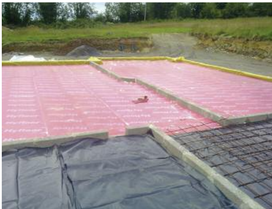
Figura 4. Ejemplo de aplicación de una barrera anti-radón.
