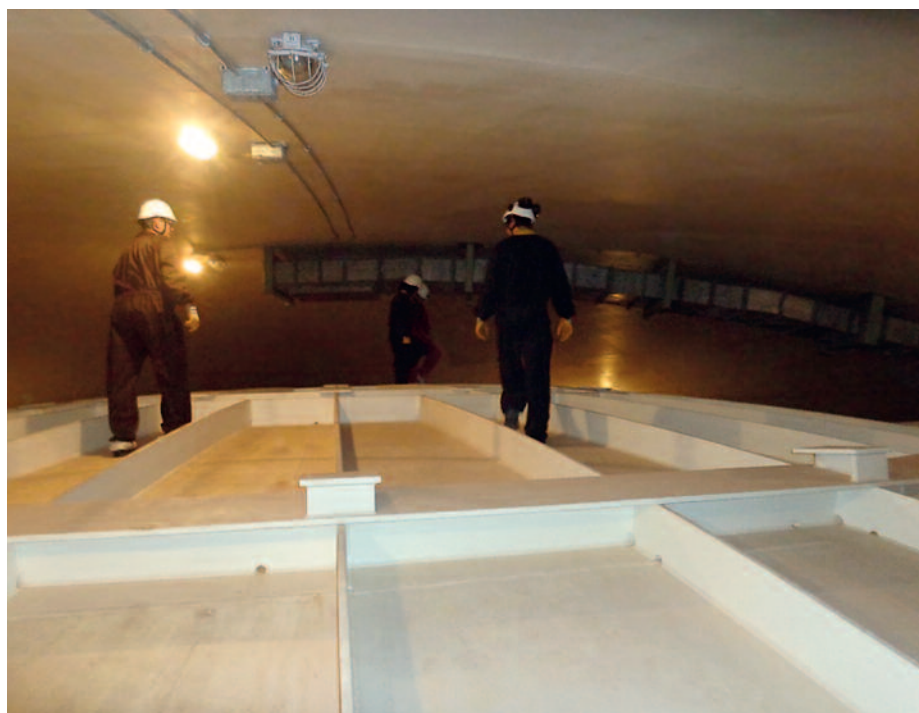
Parte superior contención metálica de un BWR (trabajos de inspección visual).
