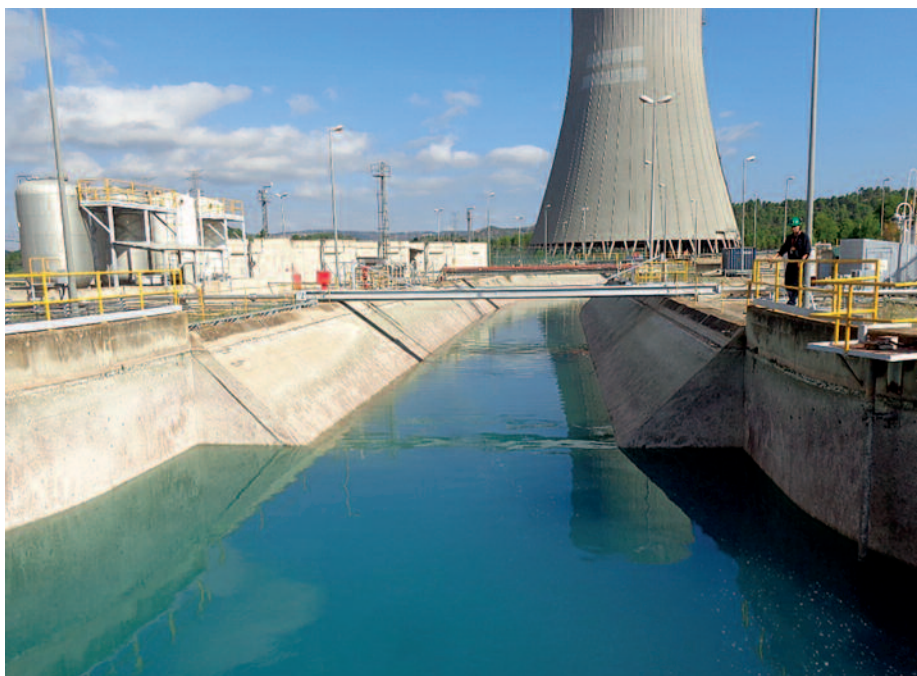
Canal y torres de refrigeración del agua de circulación en un BWR.
