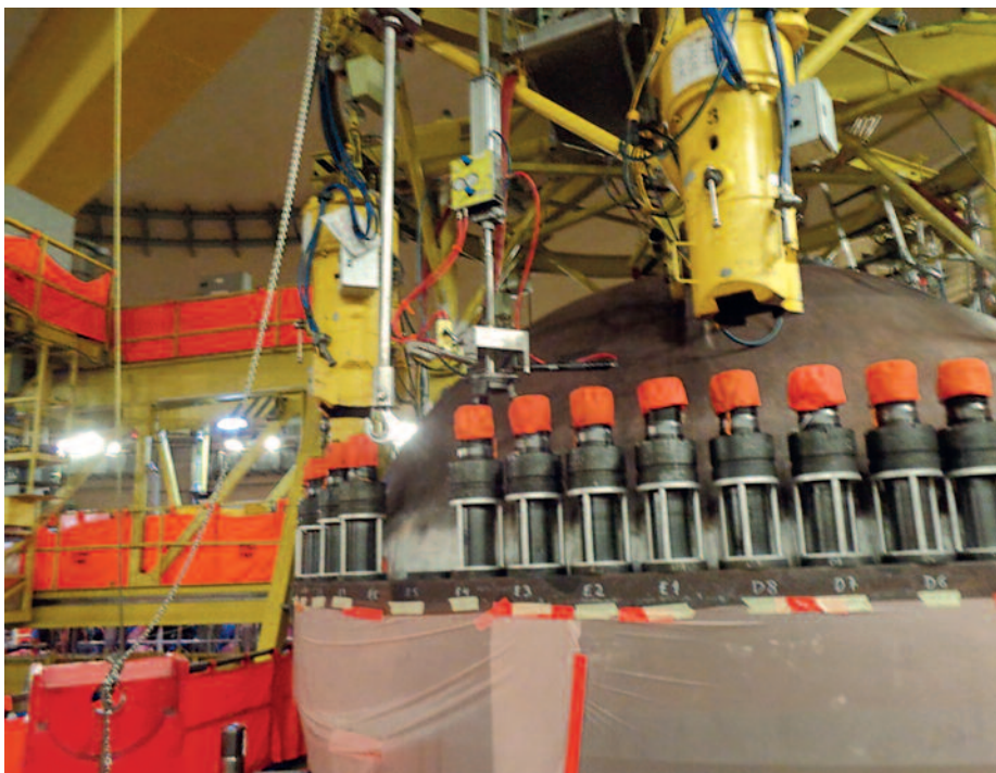
Tapa vasija BWR y equipo de sujeción e izado.
