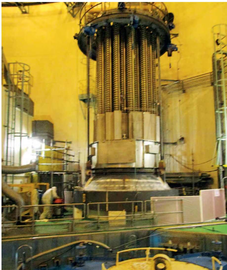
Tapa de la vasija e internos superiores (MABC) en su stand de acopio.
