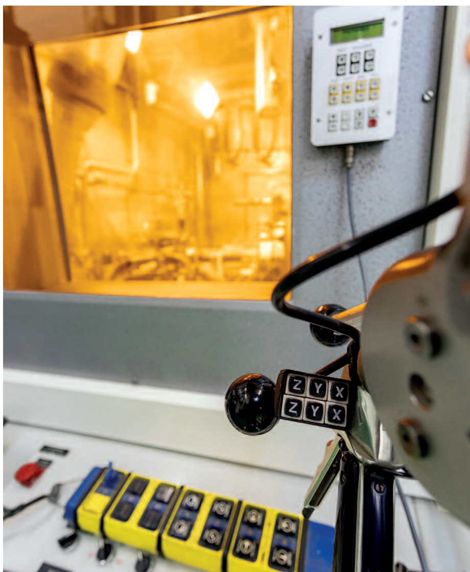
Telemanipuladores celda caliente del laboratorio activo.
