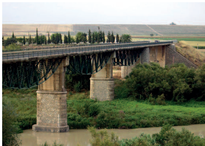
Este puente sobre el Guadalquivir es muy singular, ya que solo existen dos del mismo tipo en Europa, al tener los arcos debajo del puente (Eduardo Torroja y Miret, 1951).
