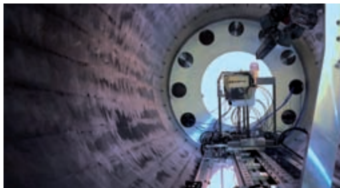
Instalación HIE-ISOLDE del CERN.
