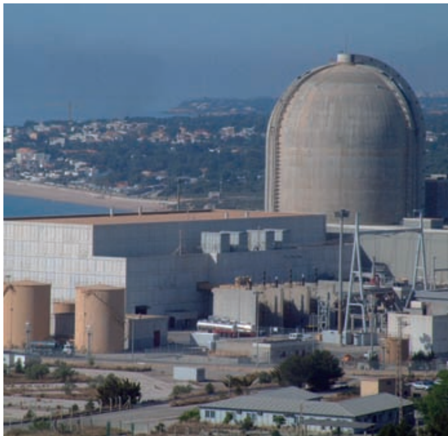
Vista panorámica del exterior de la central nuclear Vandellós II.
