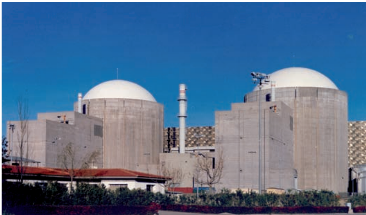
Exterior de la central nuclear de Almaraz.
