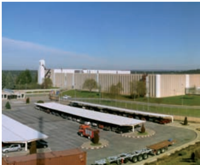
Exterior de la fábrica de combustible nuclear de Juzbado.
