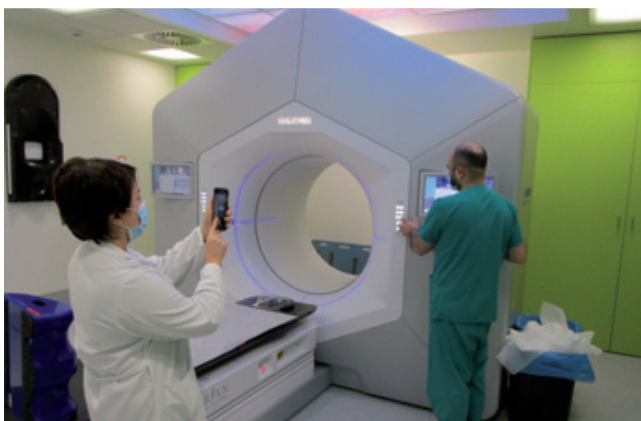
Inspección telemática del acelerador en el interior del búnker.
