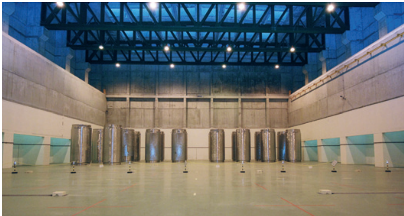
Almacenamiento Temporal Individualizado (ATI) de la central nuclear de Trillo, en Guadalajara.
