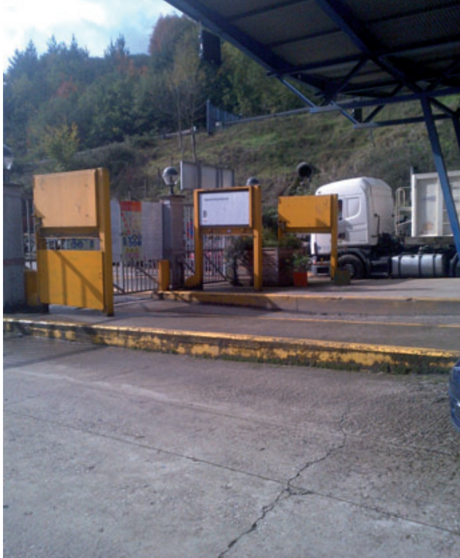
Equipo de vigilancia radiológica de la chatarra en una instalación siderúrgica.
