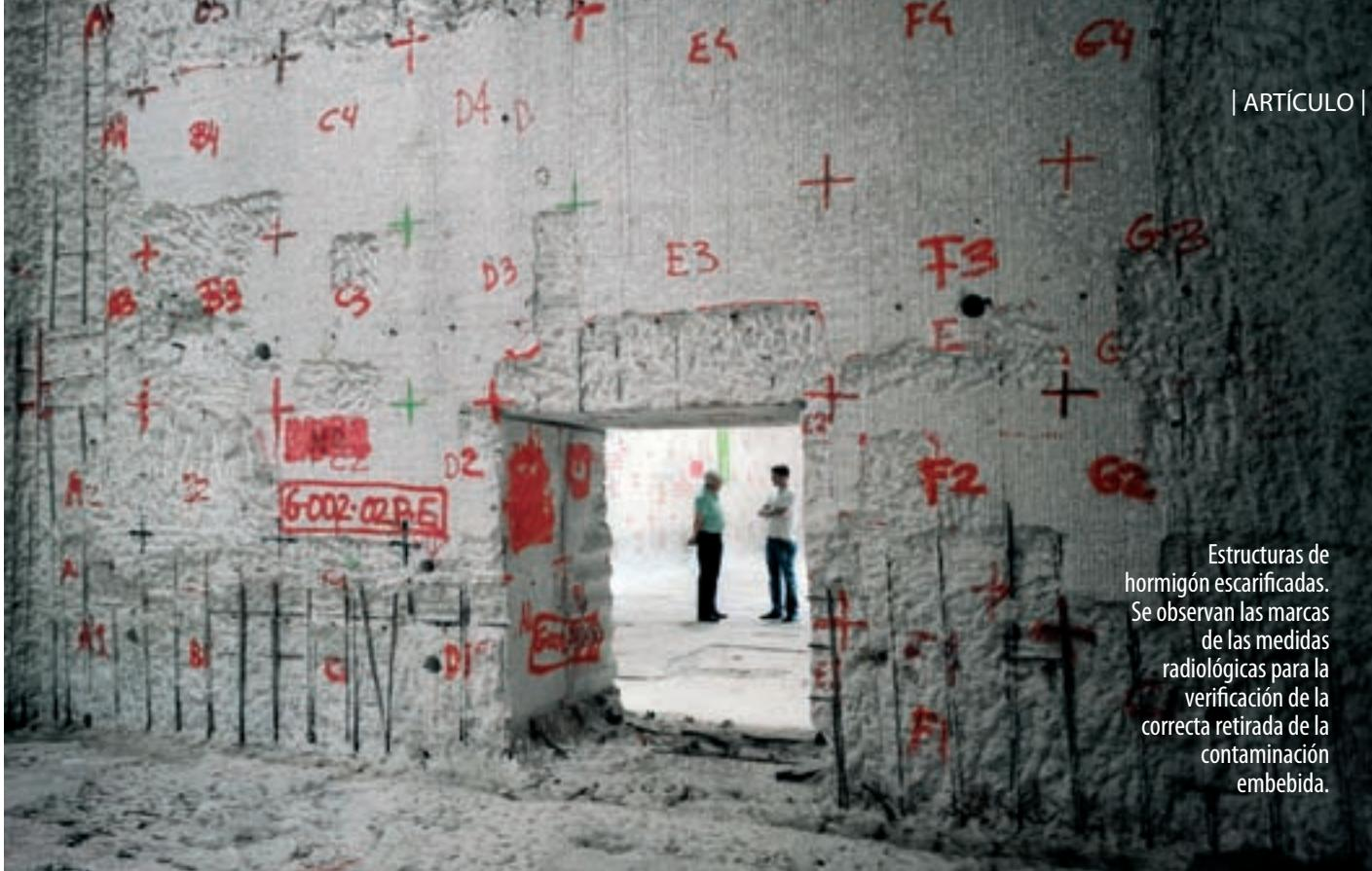
Estructuras de hormigón escarificadas. Se observan las marcas de las medidas radiológicas para la verificación de la correcta retirada de la contaminación embebida.
