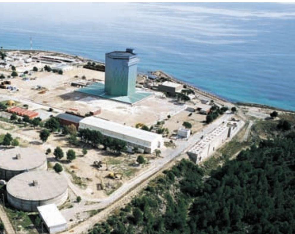
La central nuclear Vandellós 1, actualmente en la fase de latencia, como ejemplo de un desmantelamiento diferido.
