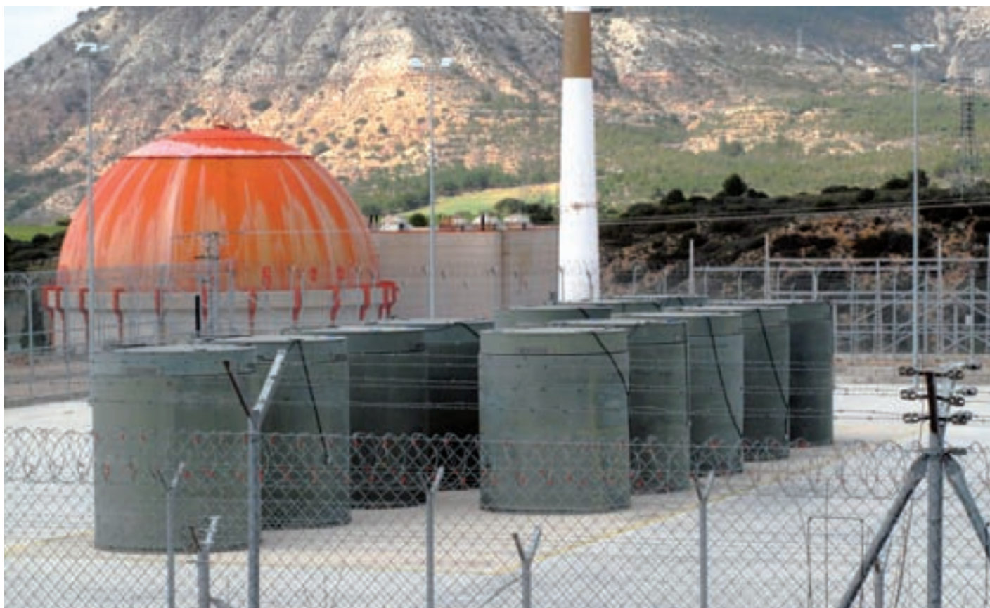
Almacén temporal Individualizado (ATI) de la central José Cabrera, como estructura auxiliar para el desmantelamiento.
