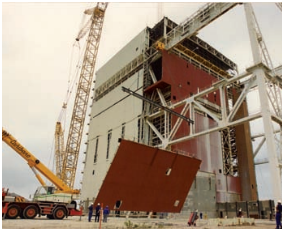
Demolición del edificio de reactor de la central nuclear Vandellòs 1.
