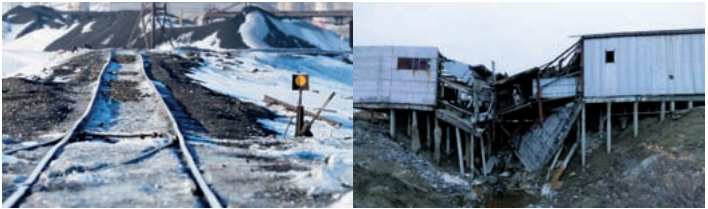
Efectos del derretimiento del permafrost en infraestructuras y viviendas de la tundra en Rusia.
